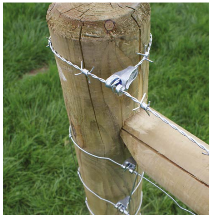
T-Clip 2 – instalováno na ostnatém drátu
