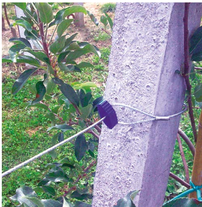
Sada instalovaná na betonovém sloupku
